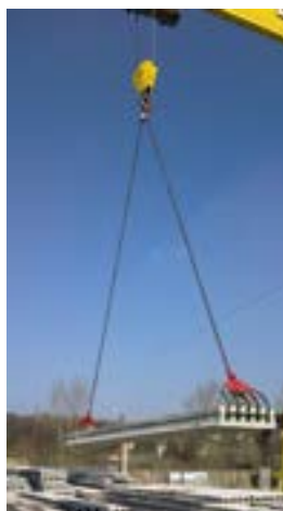
Rysunek 4 Przenoszenie płyt za pomocą zawiesi hakowych Rysunek 5 Długość i kąt zawiesi podczas przenoszenia paneli SMART
