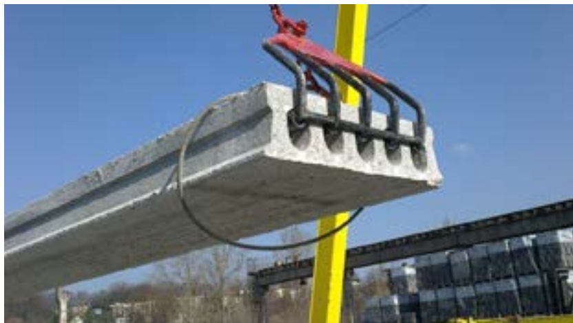
Rysunek 3. Przenoszenie paneli SMART za pomocą chwytaków
