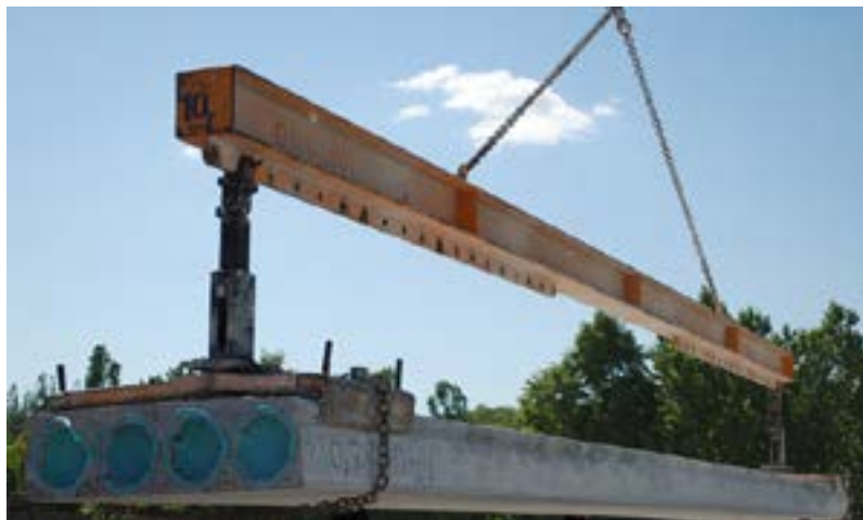
Rysunek 1. Przenoszenie płyt stropowych za pomocą trawersy
