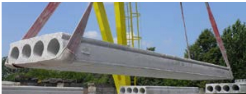
Rysunek 2. Przenoszenie płyt za pomocą pasów
