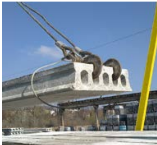
Rysunek 4 Przenoszenie płyt za pomocą zawiesi hakowych Rysunek 5 Długość i kąt zawiesi podczas przenoszenia paneli SMART
